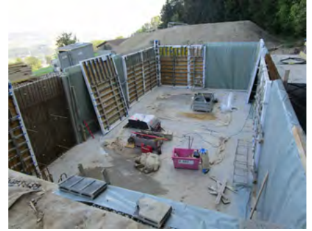
Staudenschachen in Root im Bau.
