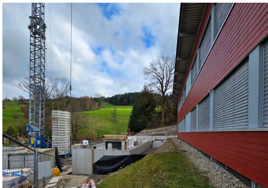
Aktuelles Bild der Baustelle beim Anbau des Schulhauses.
